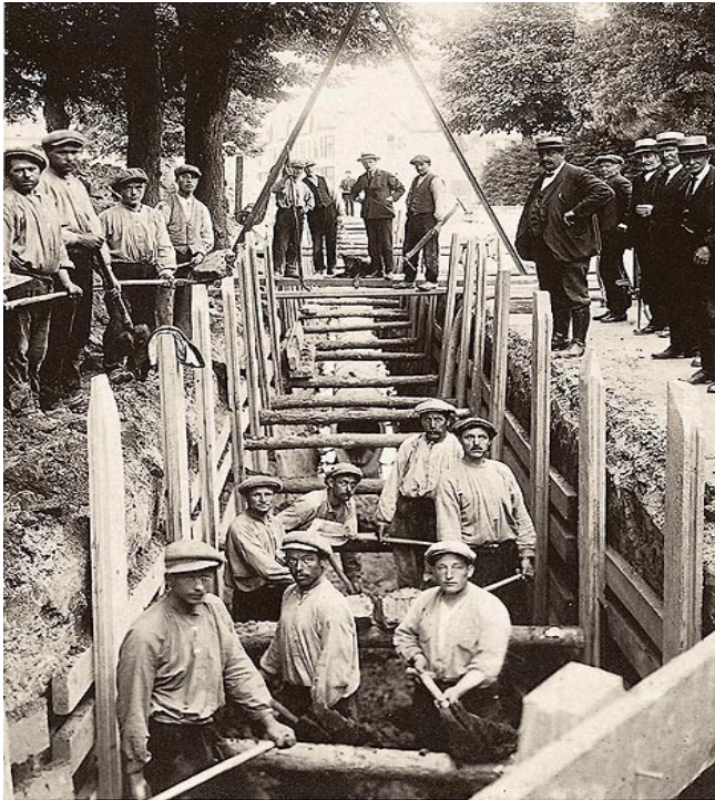
Afbeelding 1. De aanleg van riolering eind 19e eeuw.
